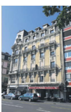
La brasserie Handwerk.
